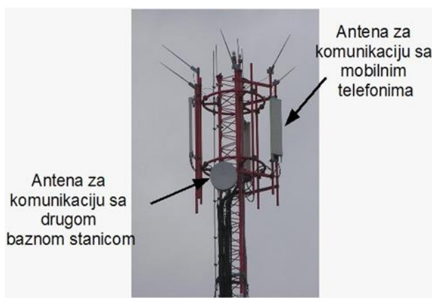
На БСМТ постоје антене за комуникацију са мобилним телефонима и за комуникацију са другим базним станицама
